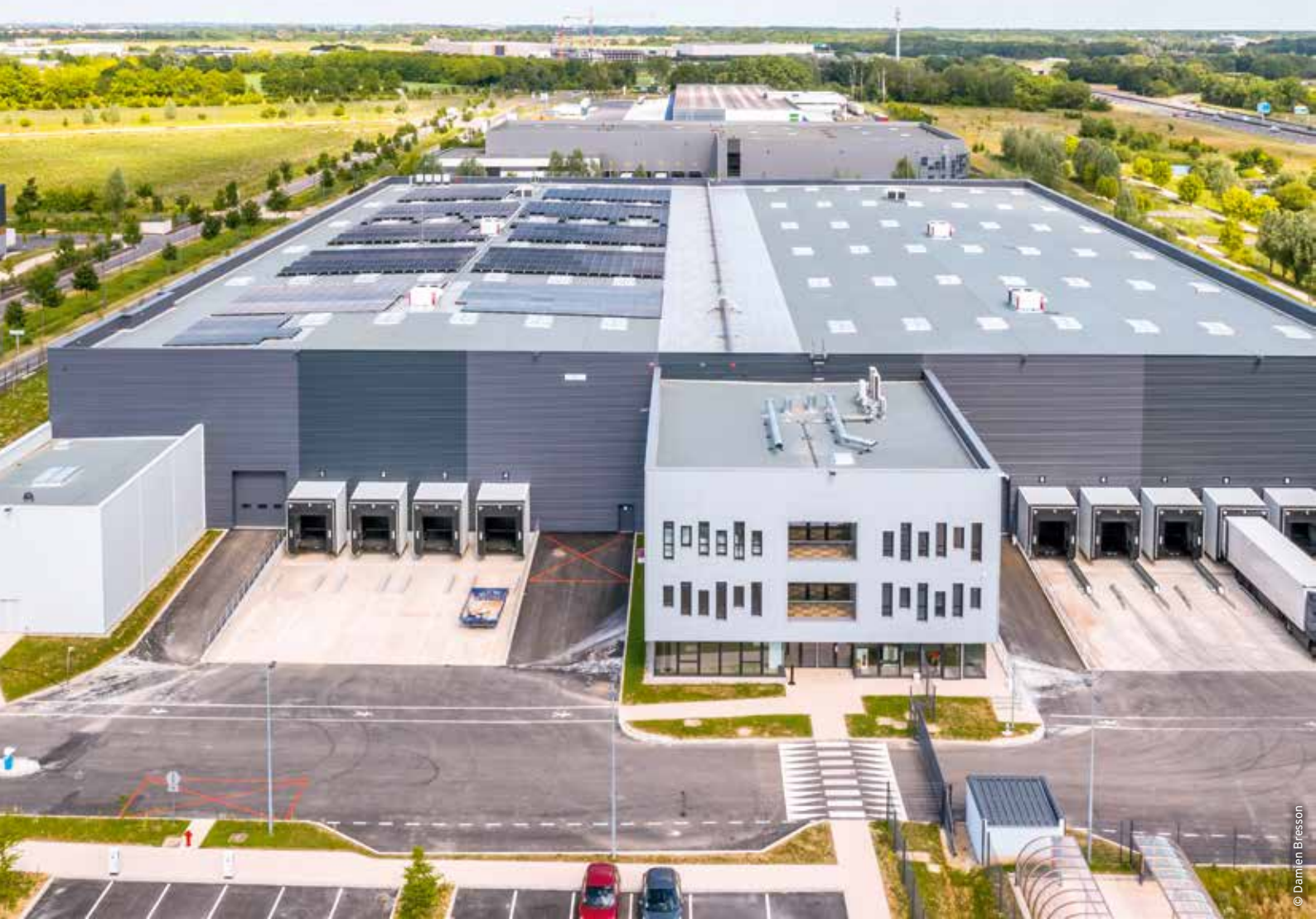
AutOnom®, l'entrepôt à énergie positive et bilan carbone neutre, Serris
