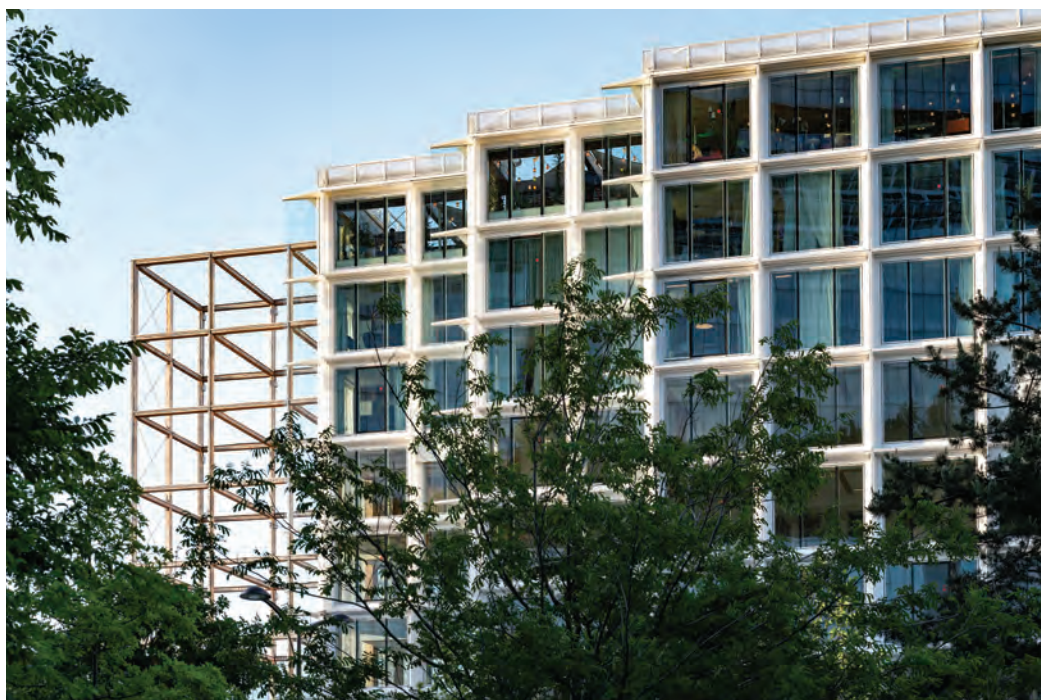
Stream Building , lauréat de « Réinventer Paris », est un immeuble multi-usages construit en bois et béton. Ses qualités environnementales sont exemplaires : il est certifié HQE Exceptionnel, BREEAM Excellent et labellisé BBCA et E+C-. © Olivier Ouadah
