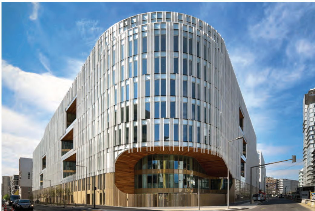
Origine , situé à Nanterre, est l'œuvre de Maud Caubet. Immeuble aux multiples certifications et labellisations, l'ensemble est nommé par le G20 parmi les 100 bâtiments durables dans le monde en 2023. Origine accueille à ce jour les entreprises Technip Energies et EDF Énergies renouvelables. © Franck Badaire
